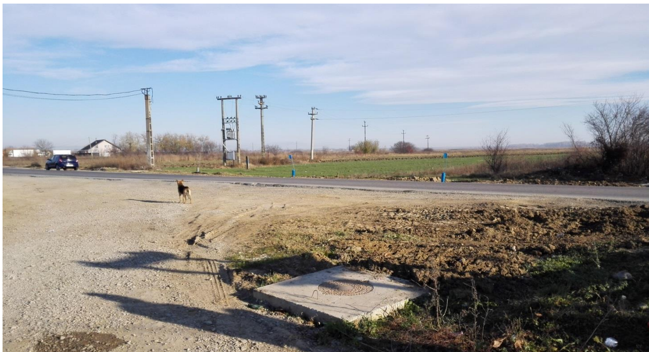
Foto nr. 1 – Conductele de transport titei Ø 12 3/4" si Ø 14" Cartojani-Ploiesti la subtraversare DN 1A, Zona Crivat-Catunu, com. Cornesti, jud. Dambovita
